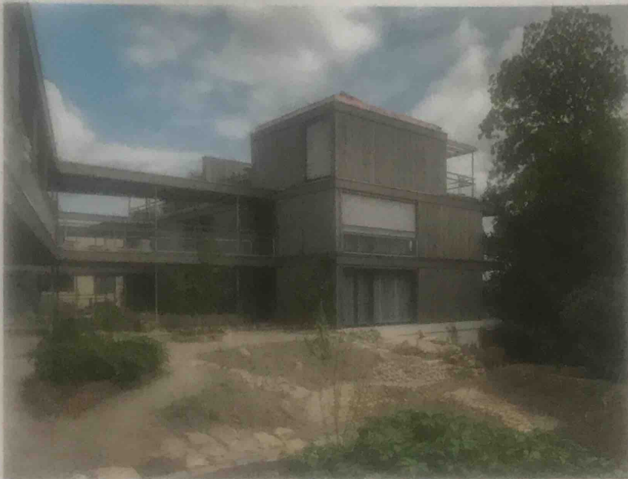
Die neue Wohnsiedlung «In den Bäumen» im zürcherischen Egg soll mit der Zeit hinter Grün verschwinden.
